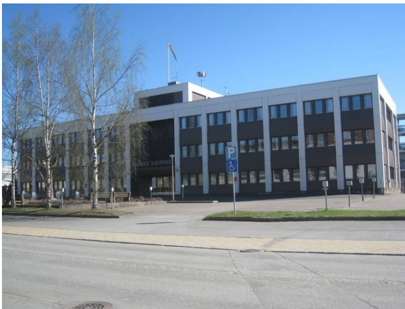
Kuva 6. Suunnittelualueella sijaitseva rakennus, Rautatalo. Näkymä Sovionkadun puolelta.
